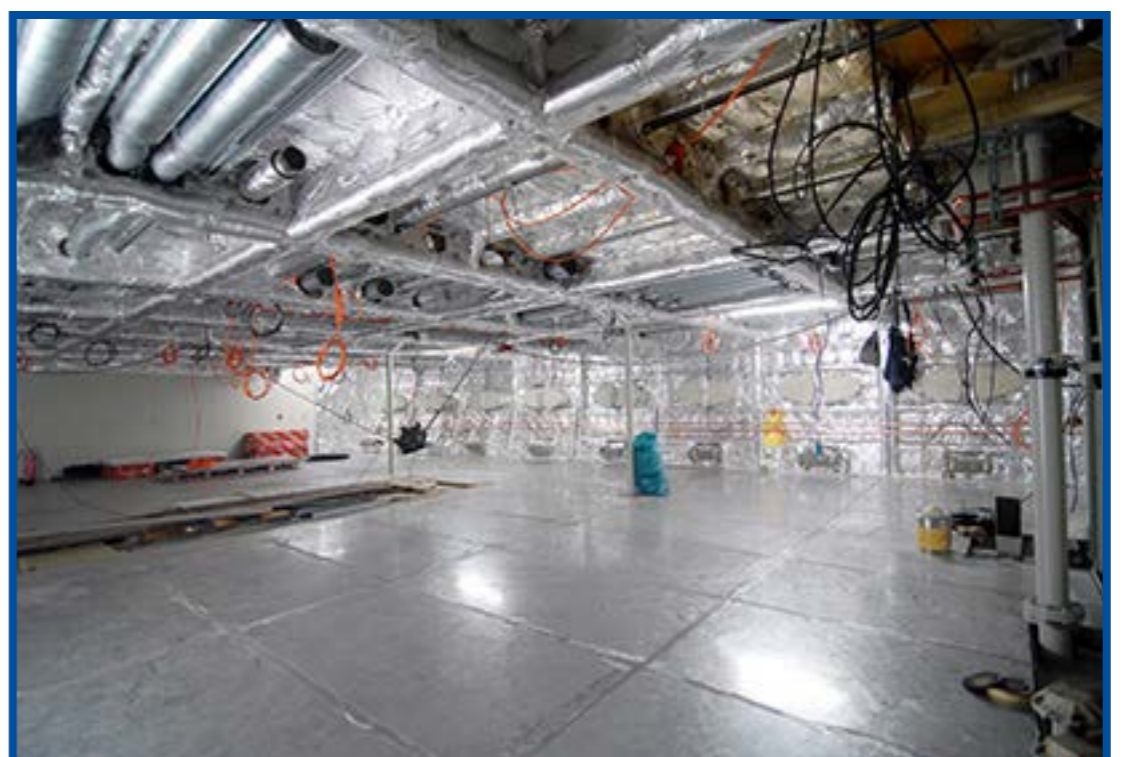
Ausbaustufe des vorderen Salons
