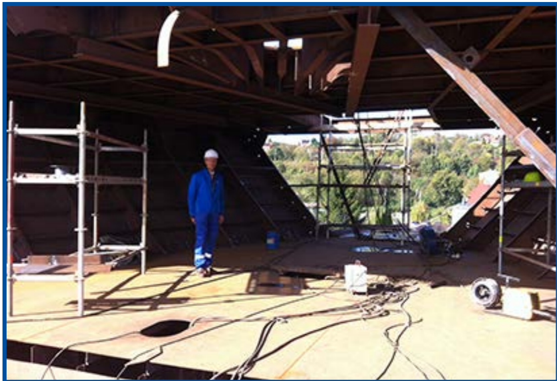
Blick in den Laderaum
