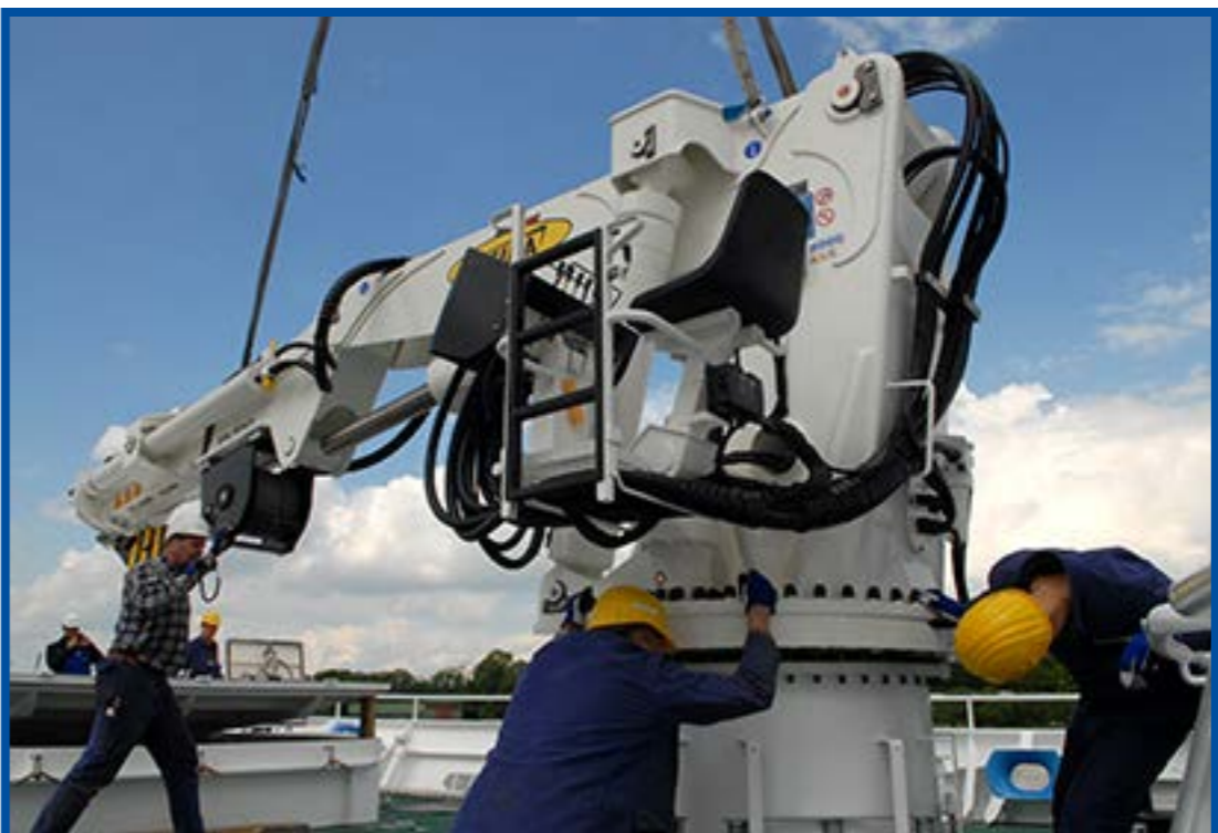
Montage des Krans
