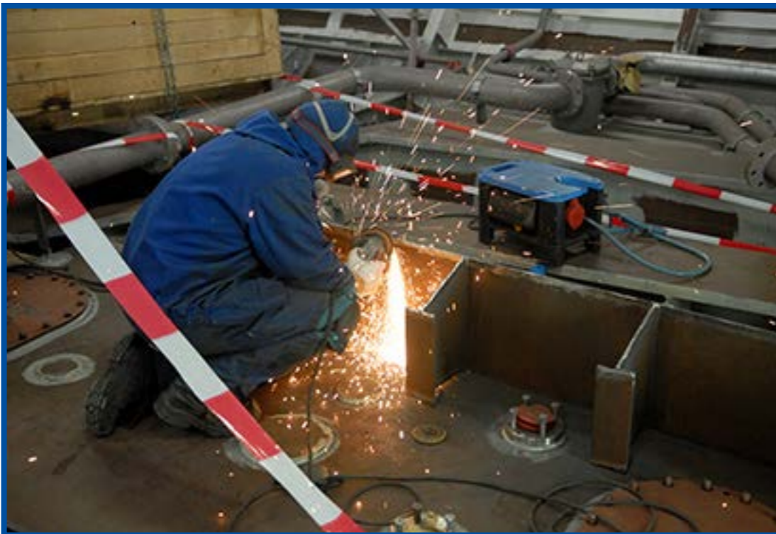
Schweißarbeiten am Neubau
