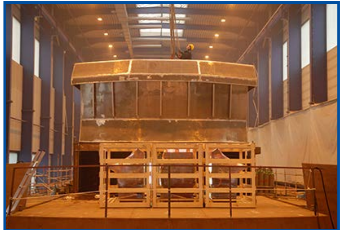
Blick auf die zukünftige Brücke
