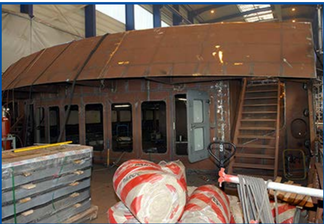
Blick von Steuerbord achtern auf die zukünftige Fensterfront
