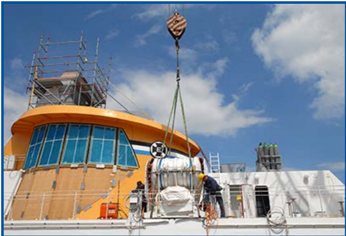
Blick auf die Brücke von steuerbord
