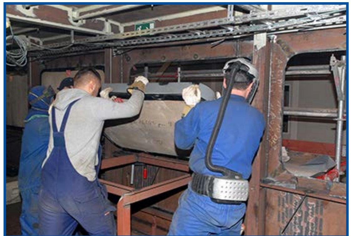
Einbau eines Fensters im Bereich Deck 3
